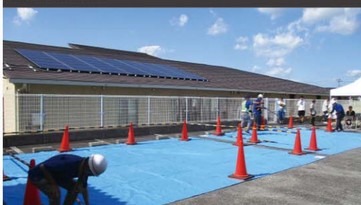
仮置場の設営
