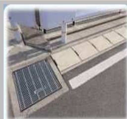
道路の側溝・集水柵
