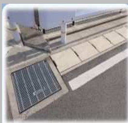
道路の側溝・集水枥
